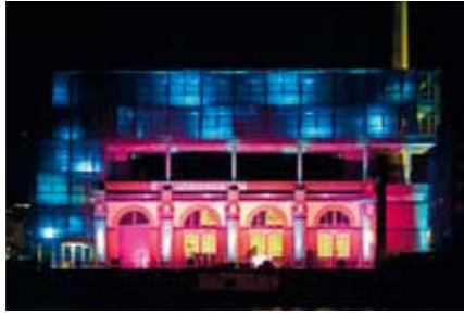
Radialsystem V Ansicht von der Spree
